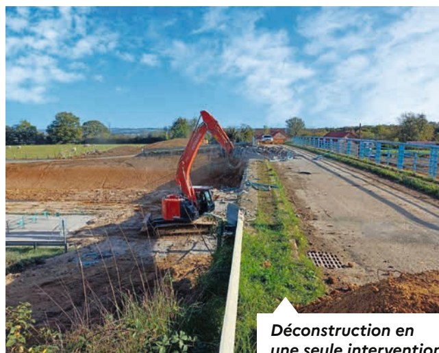
Un pont trop étroit démolit
